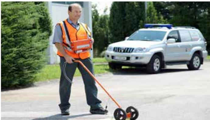
Im Zuge der routinemäßigen Wartung des Gasnetzes wird die Leitungstrasse mit einem Gasspürgerät abgegangen und auf Funktionstüchtigkeit geprüft.
